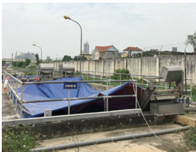
Hình 2: Khu dân cư thôn Mưỡu Giáp nằm cạnh rào bể gom nước thải nhà máy
